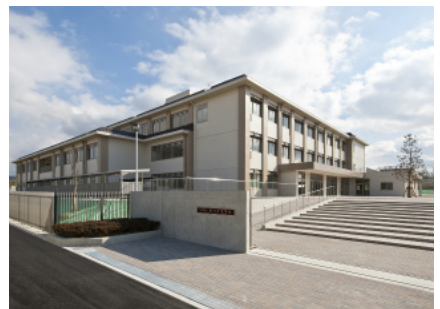
木津川市立城山台小学校
